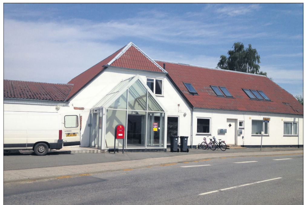
Siden januar 2013, hvor Coop besluttede at dreje nøglen om for Dagli' Brugsen i Grejs, har ejendommen på Nørre Bygade 7 stået og set kedelig ud. Men det er snart slut. Håndværkere arbejder nu på at gøre ejendommen klar til at huse et pizzeria og senere en kiosk.
